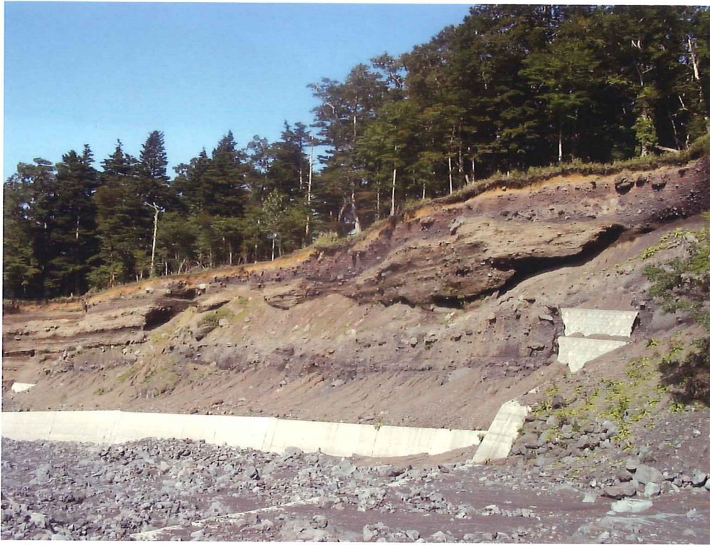
写真1 “大沢横崩れ”の全景.
