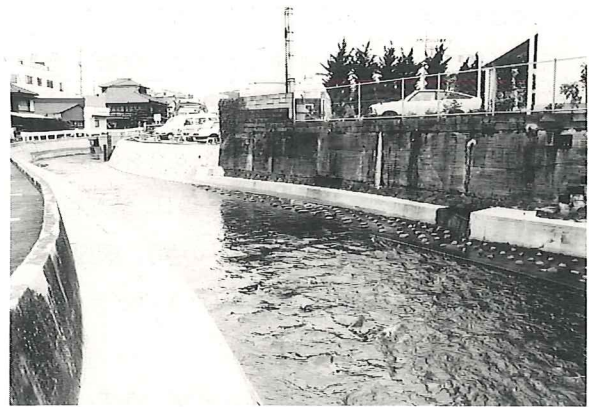
写真4：神田宮橋付近
