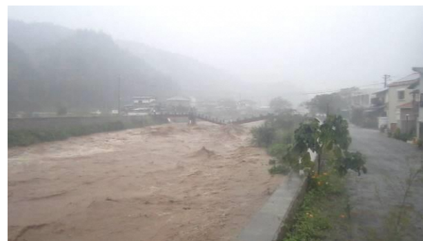
2014(平成 26)年 10 月 台風第 18 号の被害
