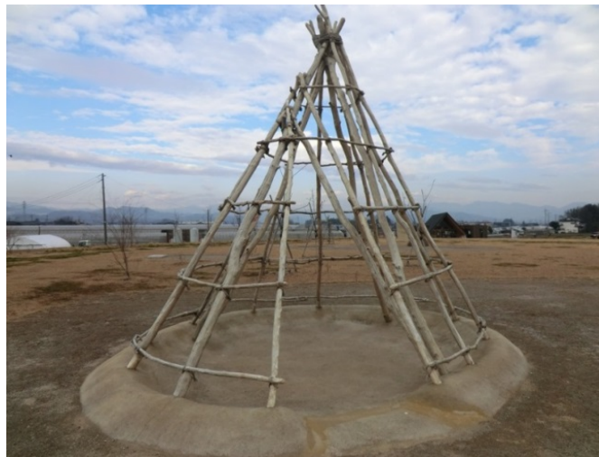
写真7 支柱のみの竪穴住居復元事例
