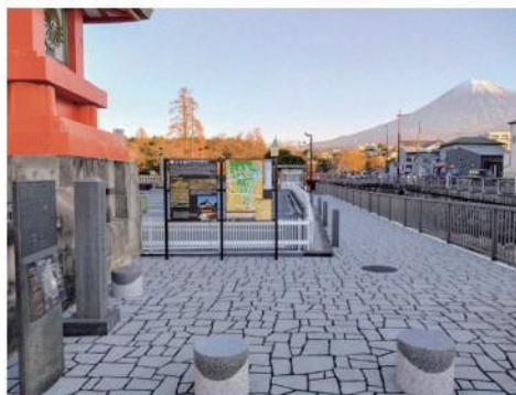
▲令和5年度宮町交番跡地歩道整備工事
