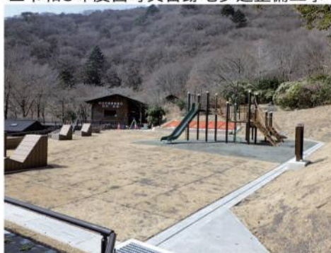
▲令和3年度田貫湖畔荘跡地整備工事
