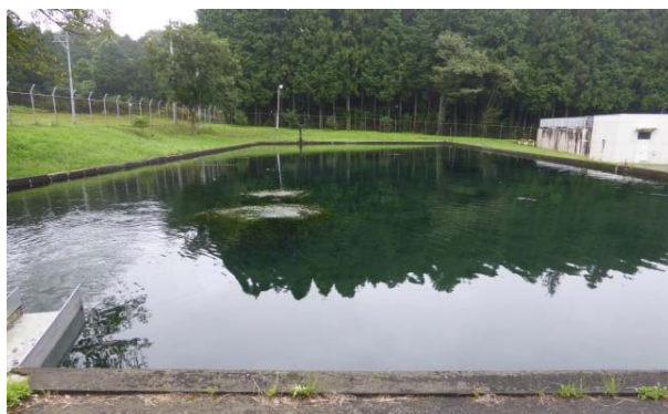
図 3-7 上井出浄水場（沈砂池）
