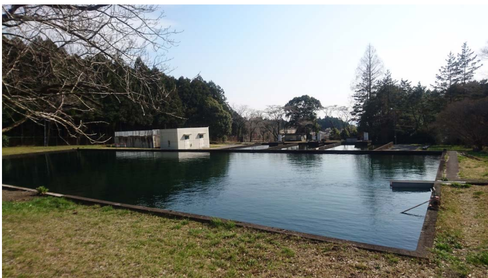
図 2-6 上井出浄水場
