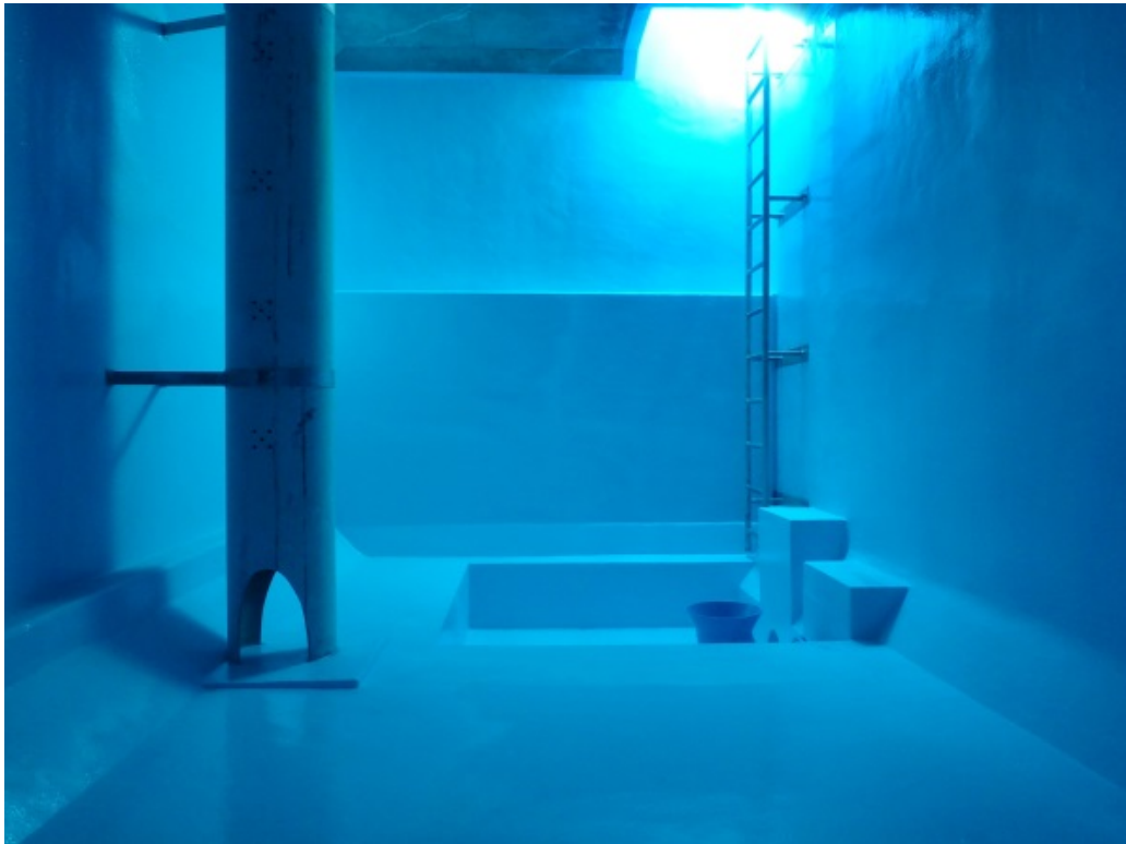
杉田第2配水池内の様子
