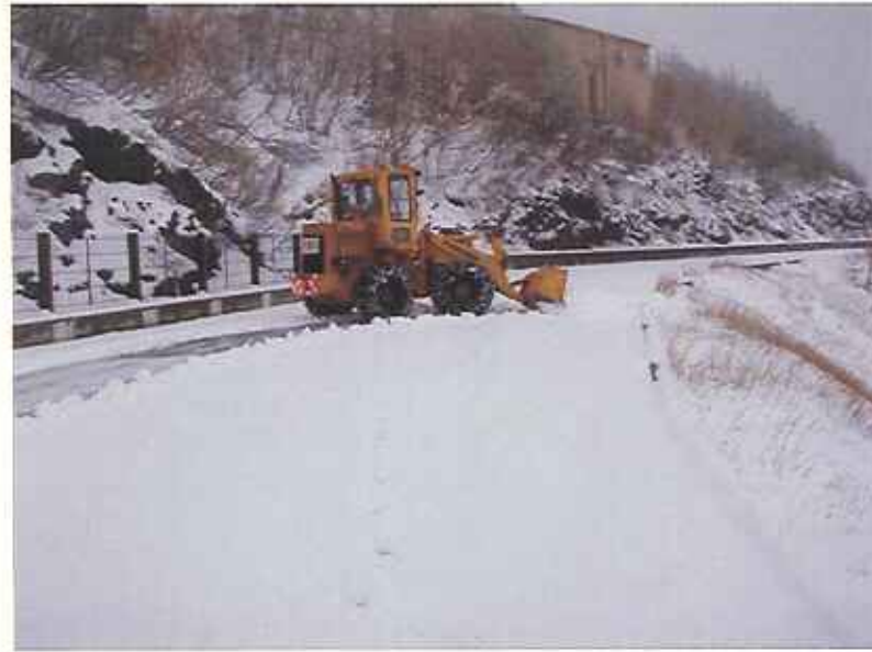
⑧ 4月の降雪および除雪作業状況(4/16撮影)
