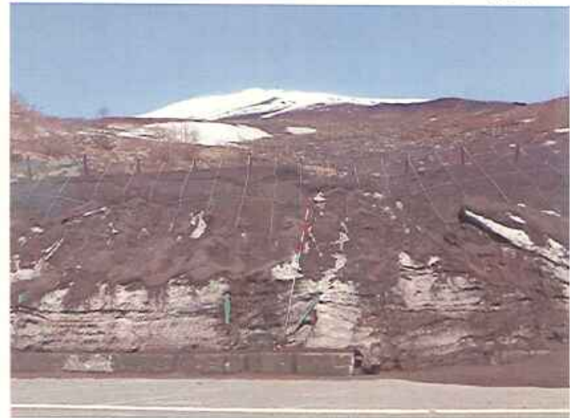
④落石防護柵及び路面への土砂流出状況(4/14撮影)
