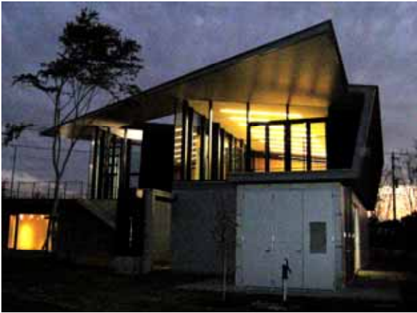
北側より会議室を望む
