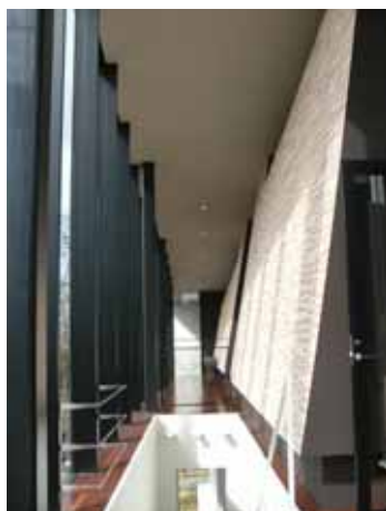
2F 蓄熱テラス
