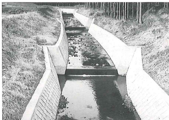
沼久保の護岸改修
