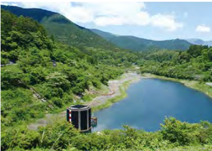
写真2-20 大倉川農地防災ダム（通常時）
