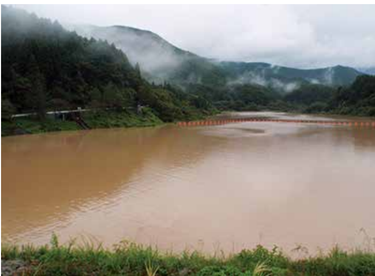
写真2-21 大倉川農地防災ダム 平成23年（2011）の台風15号の時の様子。
