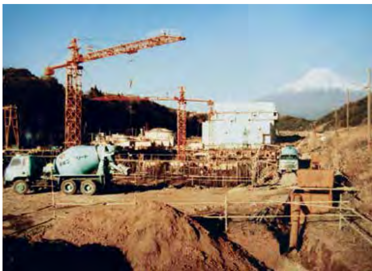
写真2-18 星山浄化センターの建設工事
