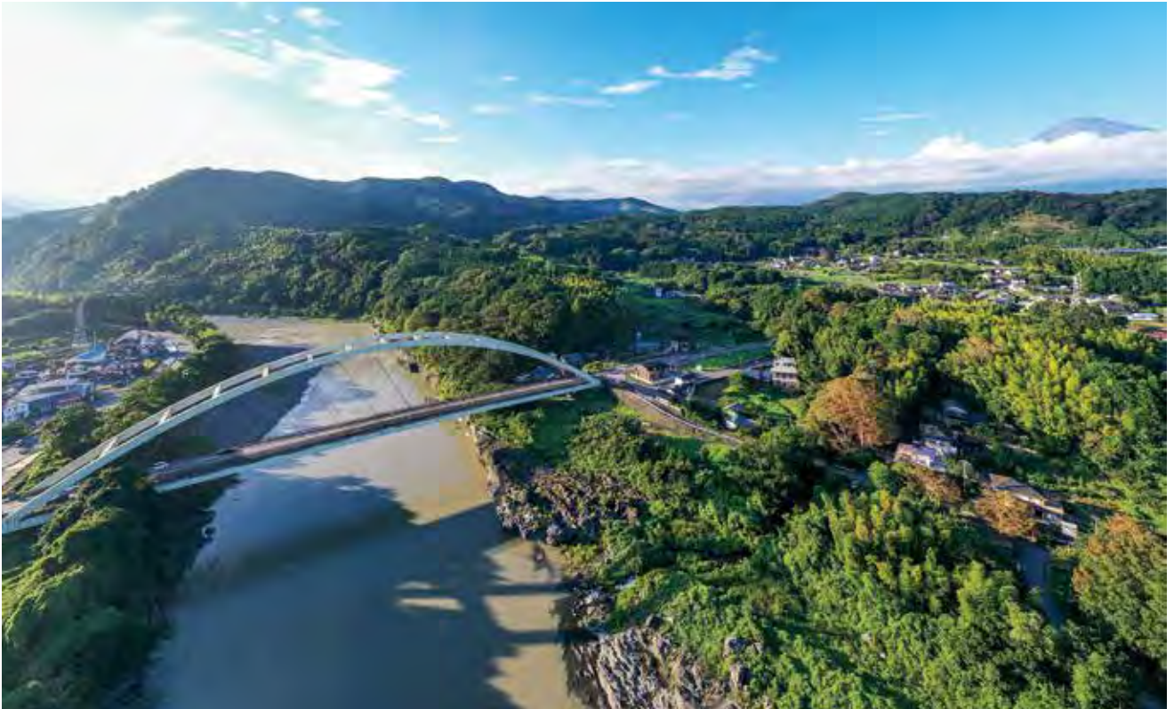
写真1-30A 空から見た富士川の蓬莱橋
