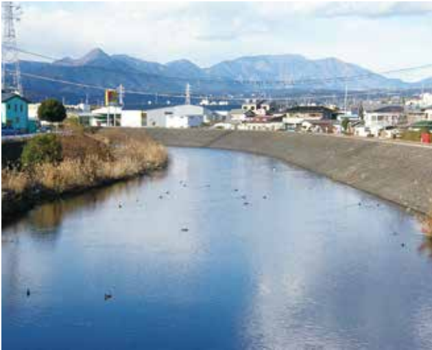
写真4-9 星山放水路水門からの潤井川
