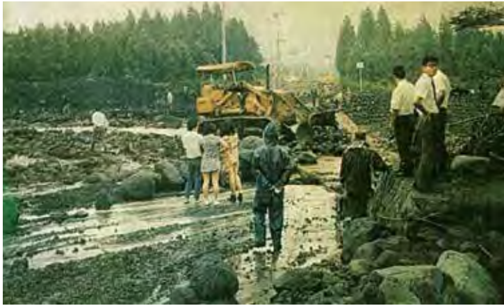
写真 2-8 上井出の県道河底橋に堆積する土砂 (静岡新聞 昭和47年(1972)7月13日 朝刊)
