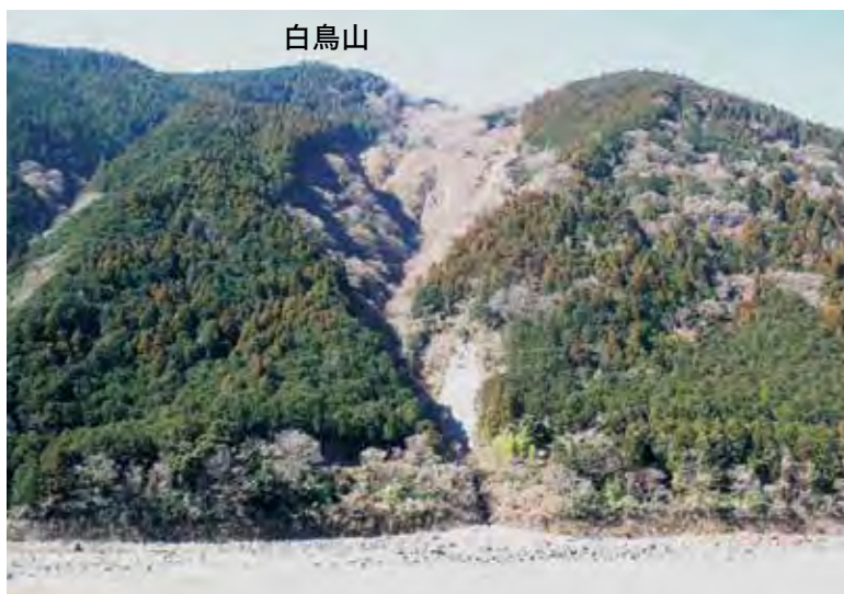
写真2-2 白鳥山崩壊地
