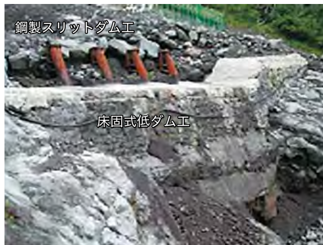
写真 2-5 床固式低ダム工と鋼製スリットダム工
