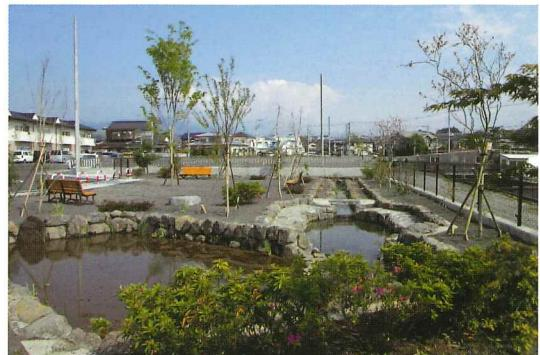
淀師地区の豊富な湧水の処理、活用について工夫されている新興住宅地です。当該地区は、地下水位が高く、一定周期で異常湧水現象を生じさせている特性があります。一般的な土地利用では、地盤改良や地下水の排水等を検討した造成を行いますが、当該地では、地下水の処理に加え、活用という付加機能について検討し施工されています。
